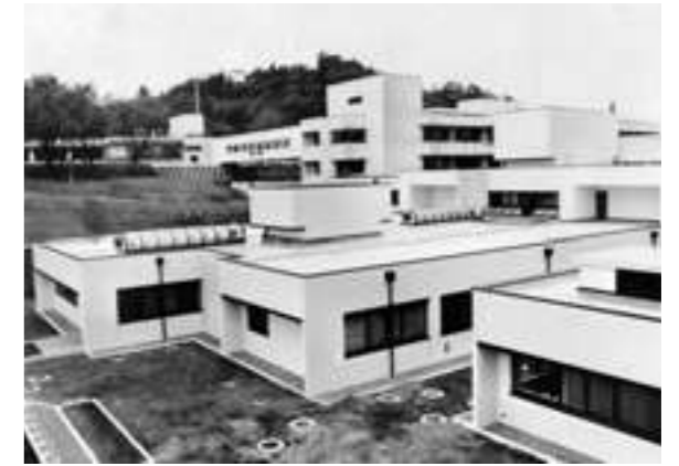
新築された三重病院
