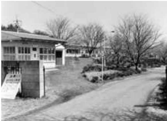
建て替える前の県立療養所三重病院
