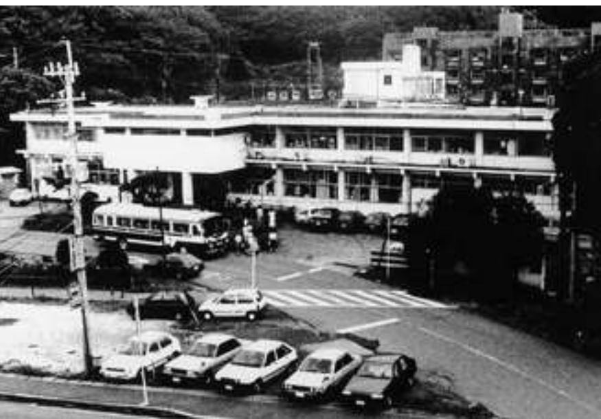
統合後の佐賀関町立病院（金山）
