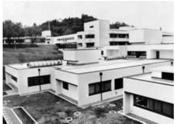
新築された三重病院
